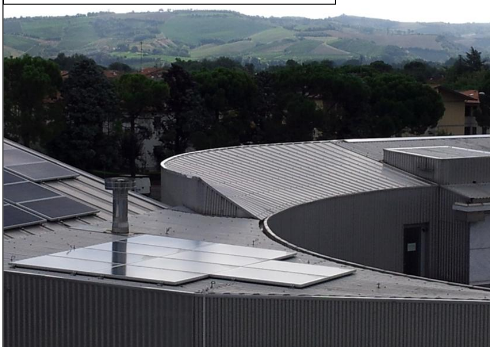
Abbildung 6: Die Photovoltaikpaneele auf dem Schuldach
